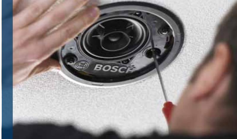
Переключатель мощности позволяет регулировать выходную мощность после установки громкоговорителя.
